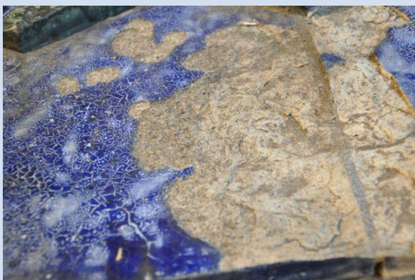
delaminatie en glazuurverlies
