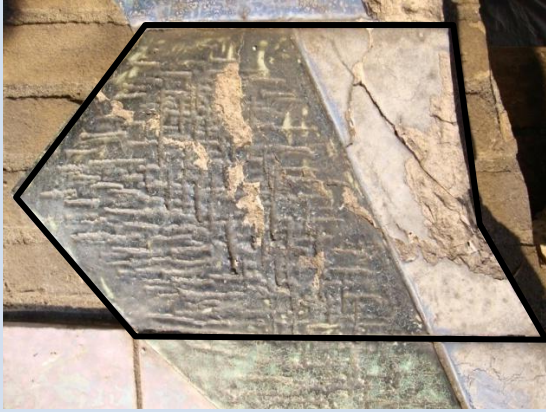
glazuurverlies door delaminatie
